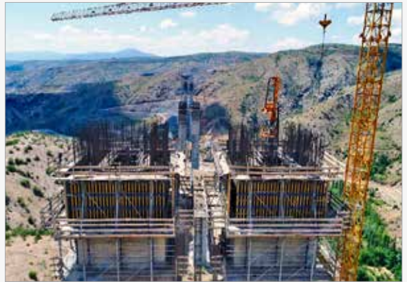
Eyiste Viaduct Project
